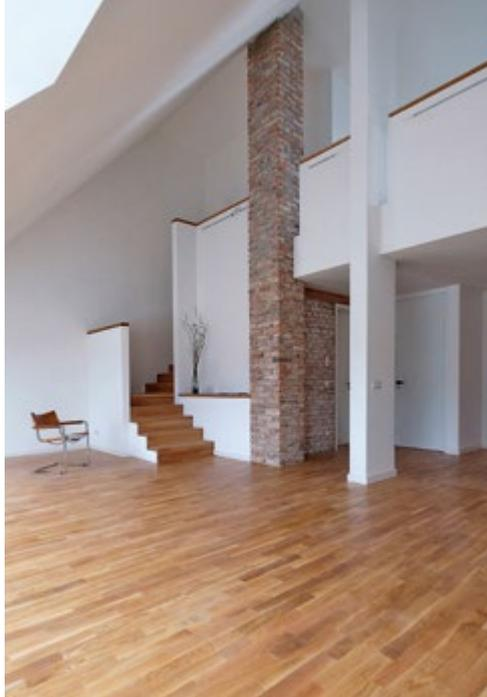
◀ Wände und Kamin der Maisonette im Dachgeschoss wurden aus recycelten Ziegeln neu aufgemauert.
