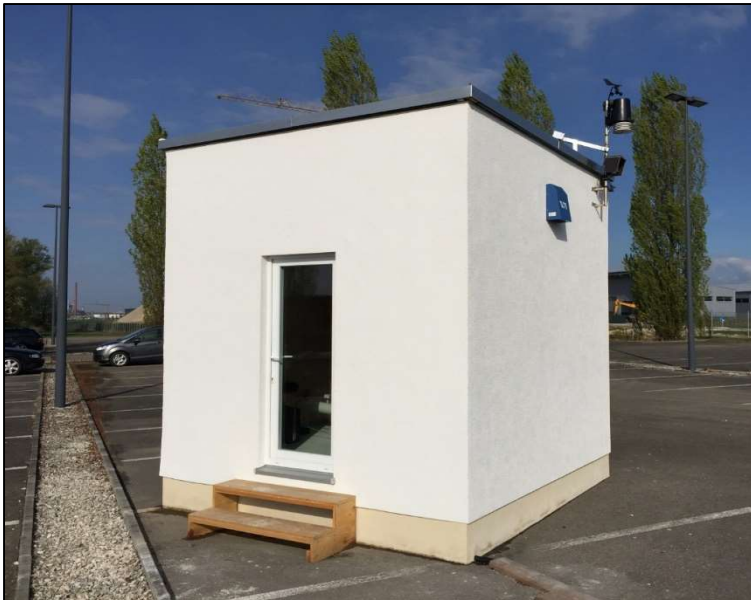
Abbildung 7: Errichteter Brettsperrholzkubus
