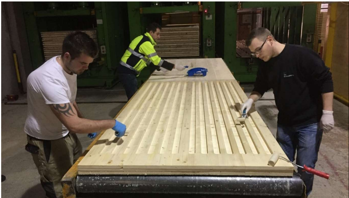
Abbildung 148: Der Auftrag des Klebers erfolgt manuell auf das rückseitige Halbelement. Die benötigte Zeit für diesen manuellen Vorgang betrug ca. fünf Minuten.
