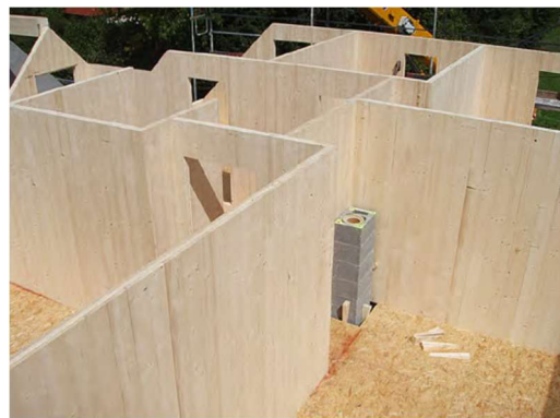
Abbildung 123: Wandtafeln aus Brettsperrholz eines Einfamilienhauses [23]
