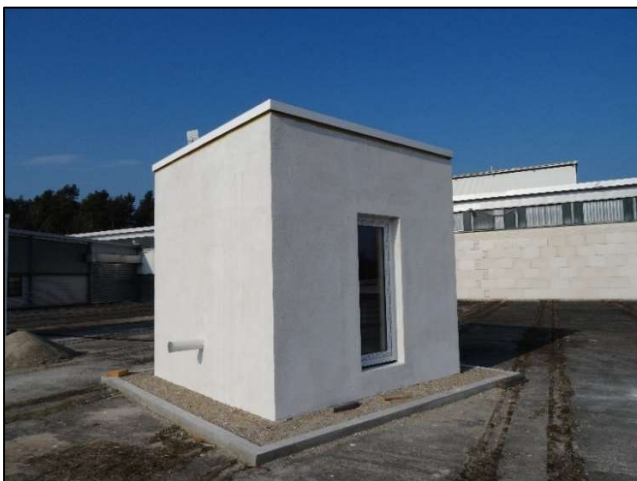
Abbildung 5: Errichteter Porenbeton-Kubus
