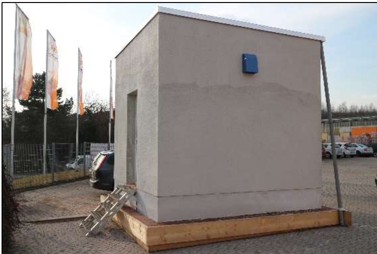
Abbildung 13: Außenansicht auf Abluftrohr
