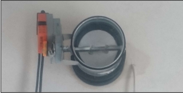
Abbildung 15: Innenansicht auf Abluftrohr
