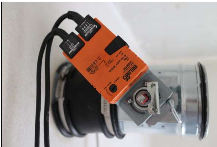
Abbildung 16: Innenansicht auf Abluftrohr
