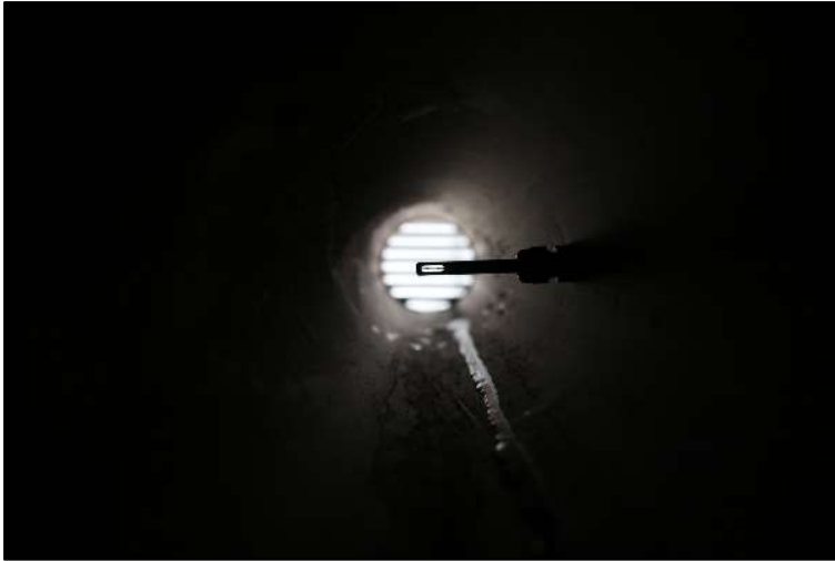
Abbildung 12: Ansicht auf Thermoanemometer
