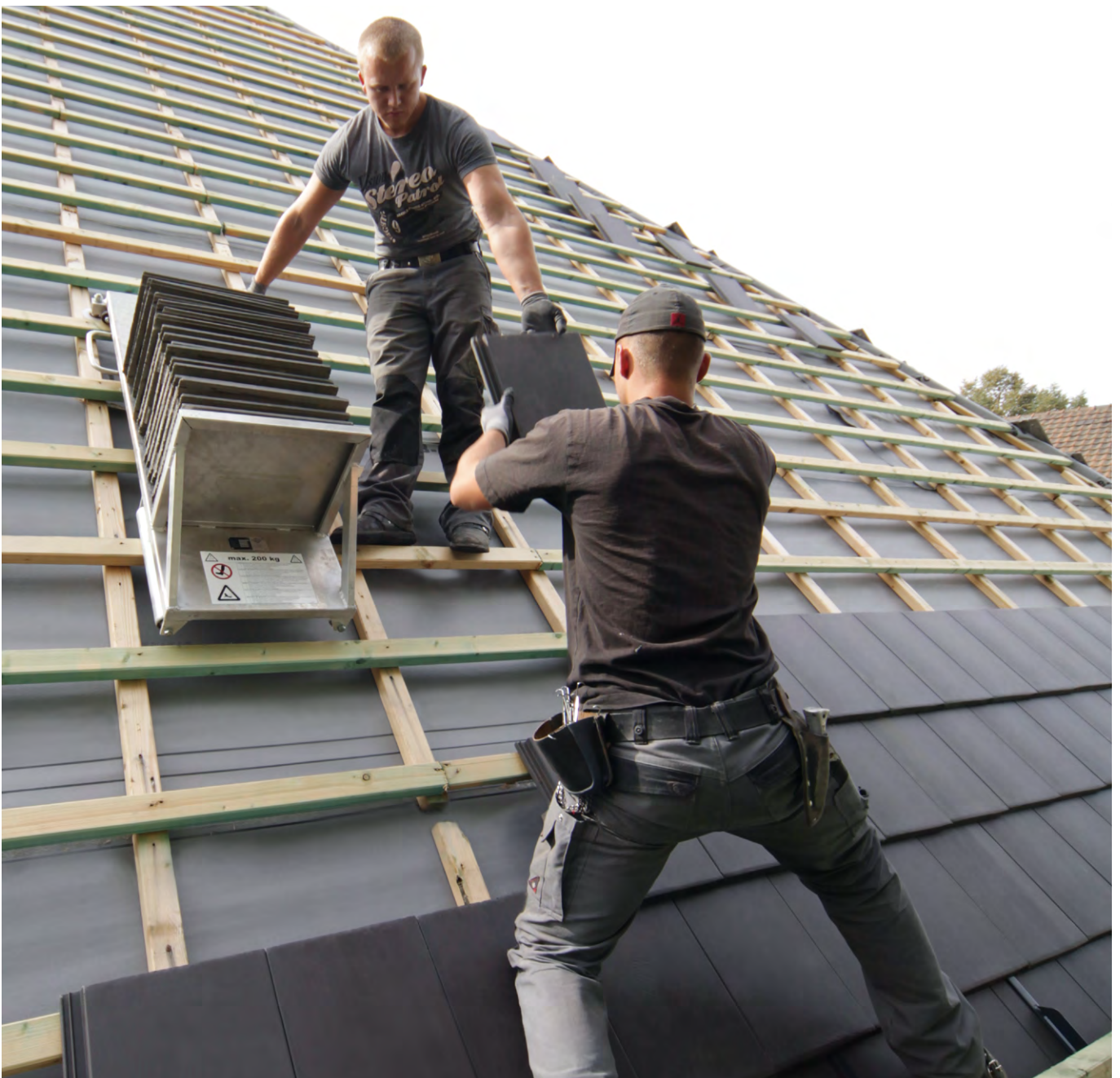
Abbildung 22: Verlegung am Dach; Quelle: BMI Steildach GmbH
