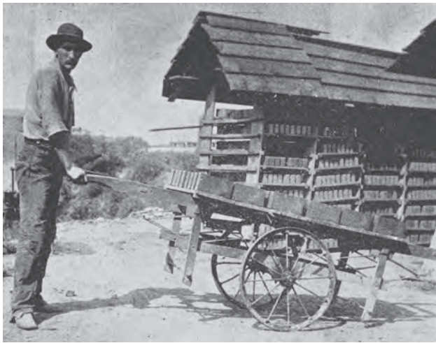
Bild 11.32. Amerikanischer Palettenwagen zum Transport der Steine von der Presse zur Trockenhürde
