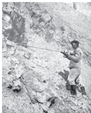
Bild 6.18. Vorbereitung einer Sprengung durch Bohren der Sprenglöcher mit dem Handbohrgerät
