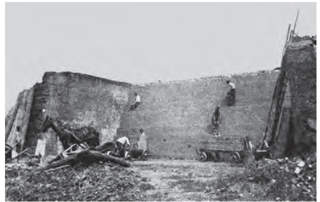
Bild 4.17. Einsetzen der getrockneten Formlinge im Waaloven, einem oben offenen, dreiseitig geschlossenen, holländischen Feldofen, um 1900
