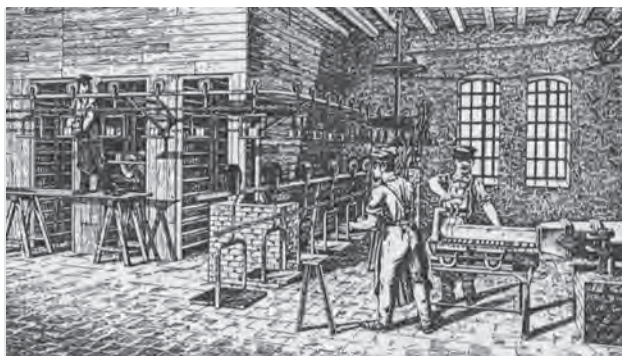
Bild 11.29. Kreistransporteur. Einlegen der Steine in die Schaukeln direkt an der Presse und Ausrüsten in der Trocknerei
