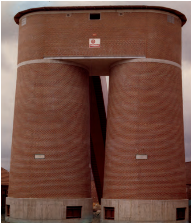
Bild 7.140. Zwei Tonsilos, Siloschacht in Ziegelmauerwerk
