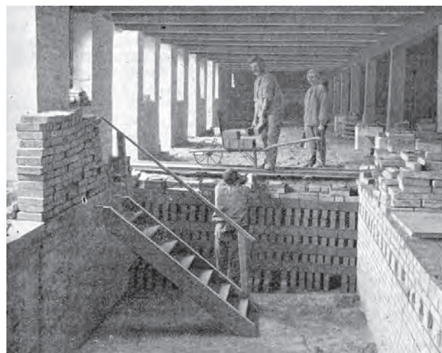
Bild 10.153. Ausfahrseite eines Erdringofens, um 1907
