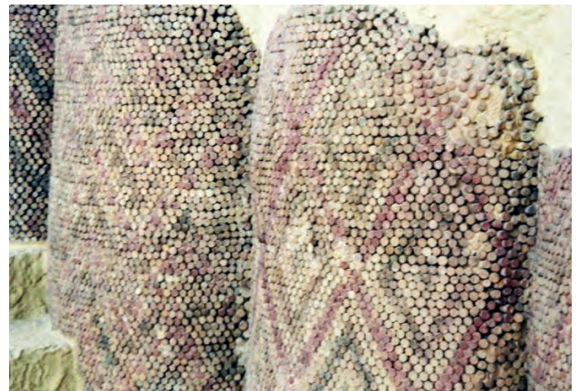
Bild 2.4b. Die Stiftmosaikziegel wurden einfach in die noch feuchte Lehmmauer gedrückt.
