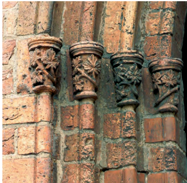
Bild 8.21. Formziegeldetail an einem Portal des Klosters Chorin: ein reichverziertes Kapitellfries trennt die senkrechten Gwändeformziegel von den Bogenformziegeln
