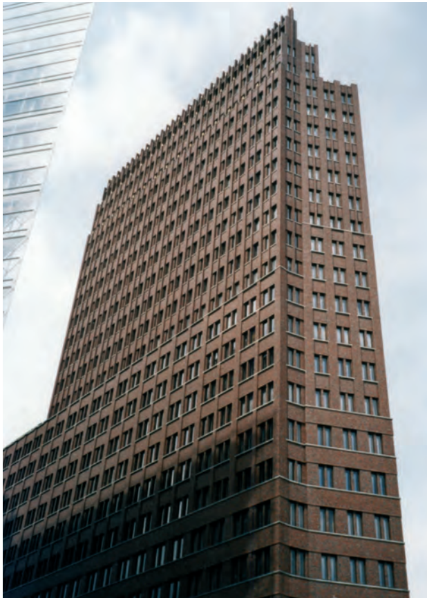
Bild 1.7.a. Kollhoff-Hochhaus: Klinker-Verblendfassade aus objektgefertigten Fertigteilen
