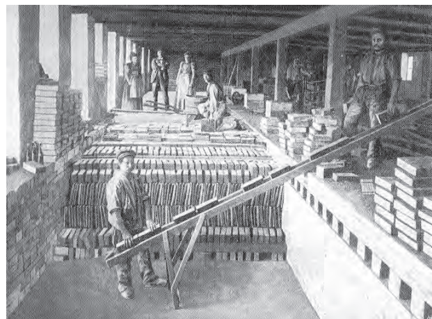
Bild 10.152. Einfahrseite eines Erdringofens, um 1907
