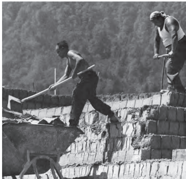
Bild 6.13. Stechen des Tons um 1920
