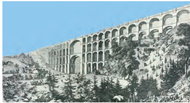
Bild 2.2. Die Göltzschtalbrücke, ein Ziegelbau, bei dem 26 Millionen Backsteine vermauert wurden, war bei ihrer Vollendung 1851 mit 574 m Länge und 78 m Höhe das mit Abstand höchste Eisenbahnviadukt der Welt.
