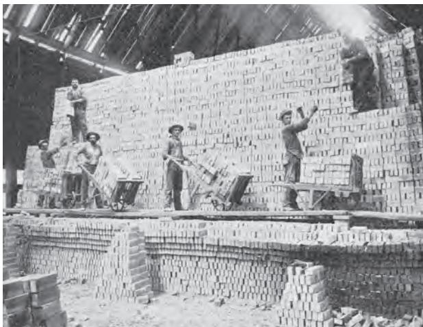
Bild 10.50. Setzer bei der Arbeit in einem Clamp-Kiln, um 1895
