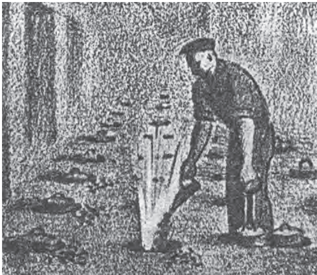
Bild 10.103b. Kohlenbefeuerung eines Ringofens durch Handschüttung
