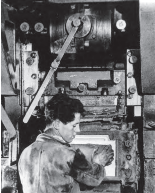
Bild 8.112. Batzen-Aufleger an einer Revolverpresse mit Handabweiser
