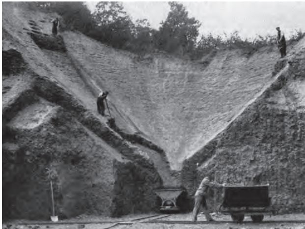
Bild 6.17. Rutschenabbau
