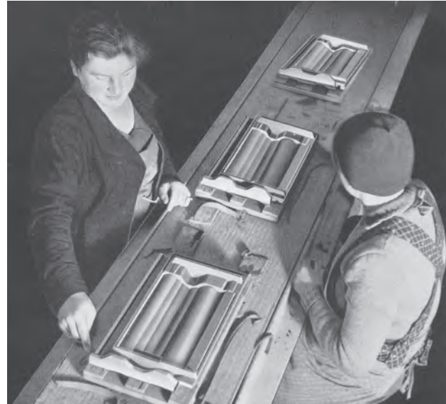
Bild 8.115a. Putzerinnen am Putztisch, der sich mit der Trommel der Revolverpresse taktweise bewegte. Noch bis in die 1950er Jahre wurden die Formlinge zum Teil noch von Hand entgratet
