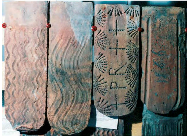
Bild 2.56a. Links: Zwei sog. Wellenbandziegel. Das Wellenband ist bei Feierabendziegeln das häufigste Motiv, das in unzähligen Varianten auftritt, da es sich mit den bloßen Fingerkuppen sehr einfach in den weichen Ton modellieren läßt. Verschiedentlich wird auch ein Kamm, eine Gabel oder eine Spachtel benutzt. Mitte: Sonnenziegel mit 11 Halbsonnen am Rand (so daß zwei nebeneinanderliegende Ziegel wieder ganze Sonnen ergeben), begleitet von drei Kreuzen und den Buchstaben PR, vermutlich die Initialen des Zieglers. Rechts: Handstrichziegel mit zwei Randstrichen, den sog. „Wasserstrichen“, und der Jahreszahl 1866
