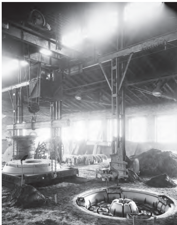
Bild 4.31. Impressionen aus der Eisengießerei der Firma Karl Händle & Söhne, Mühlacker, um 1955. Ziegeleimaschinenbau war Schwermaschinenbau, deshalb hatten fast alle Ziegeleimaschinenfabriken auch eine eigene Gießerei. Als ab den 1980er Jahren die Gußkonstruktionen jedoch weitgehend von Stahl-Schweißkonstruktionen abgelöst wurden, bedeutete dies meist auch das Aus für die Gießereien.
