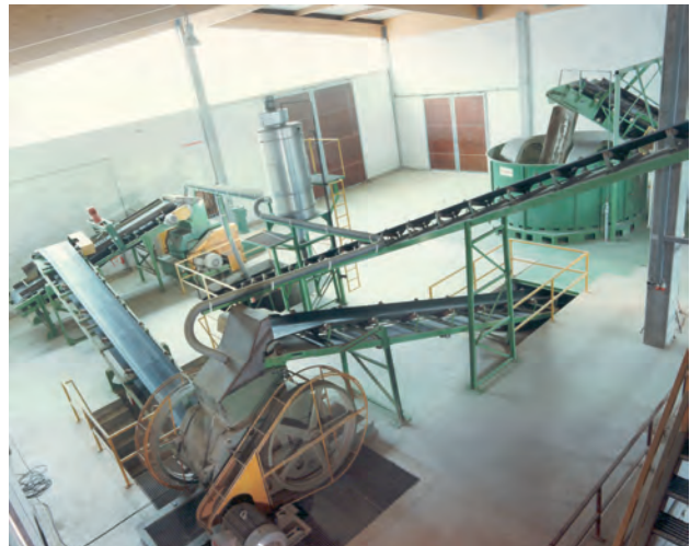
Bild 7.147. Aufbereitungsanlage um 1990: Kollergang mit mittlerer Aufgabe, Vorwalzwerk und Feinwalzwerk
