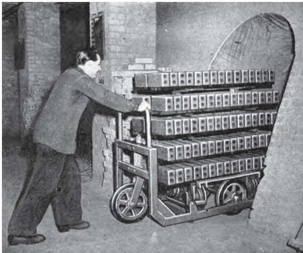
Bild 10.94. Ofensetzer beim Einfahren der Rohlinge in eine Ringofenkammer
