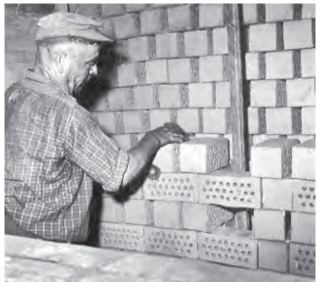
Bild 10.24. Setzer im Ringofen beim Aufbau der Heizschächte mit der Setzlatte
