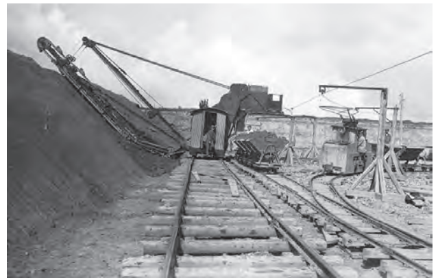
Bild 6.28. Eimerkettenbagger, als Hochbagger arbeitend
