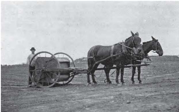
Bild 6.21b. Drehschraper zum Aufsammeln des aufgeflogenen Tons
