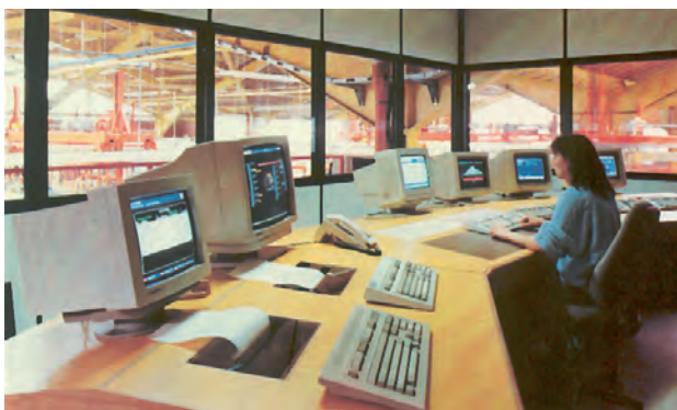
Bild 4.45. Leitstand der Trocken- und Ofenanlage eines Ziegelwerks mit Prozeßleitrechnern, um 1995
