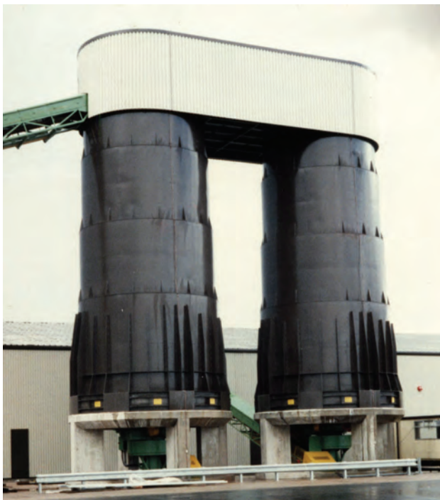
Bild 7.141. Zwei Tonsilos, Siloschacht in Stahlblech
