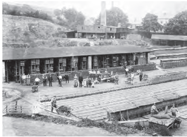
Bild 9.3. Das Bild der Handstrichziegelei von Zschopau um 1900 zeigt die Trocknung auf dem Plan, mit Strohmatten abgedeckte Trocken-Hagen und Freiluft-Trockenschuppen. (Westfälisches Industriemuseum, Fotoarchiv)
