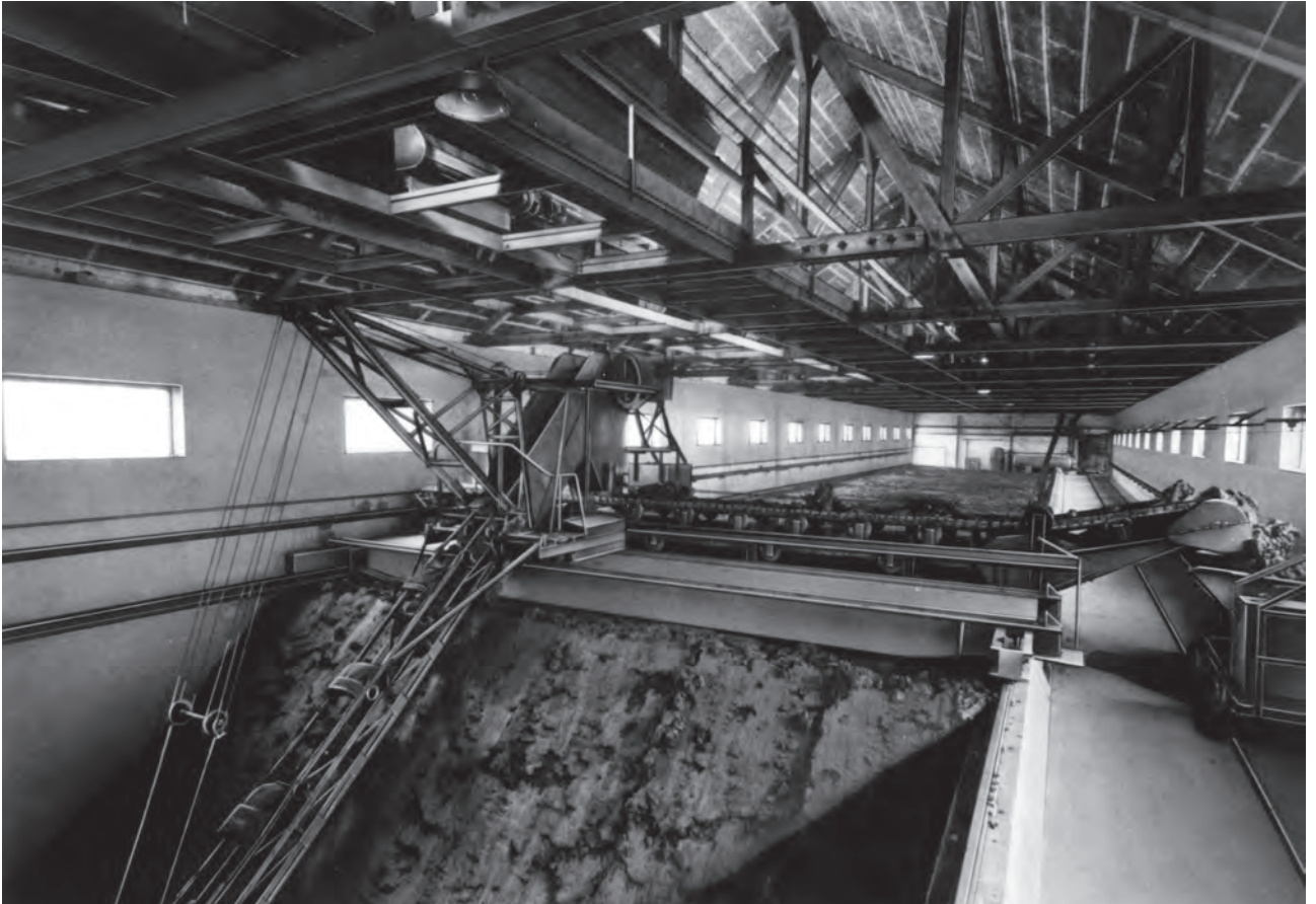
Bild 7.123. Quersumpf mit Seilzugbagger und Entleerung auf Kipploren , 1940
