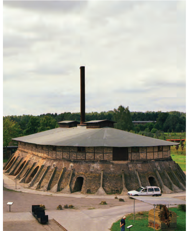
Bild 10.84. Außenansicht des Ringofens im Ziegeleipark Mildenberg bei Zehdenick, auf dem die Friedrich Hoffmann Gedenkausstellung untergebracht ist
