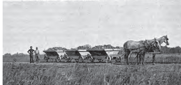
Bild 6.38. Schienengebundene, pferdegezogene Loren in einer amerikanischen Tongrube, um 1895
