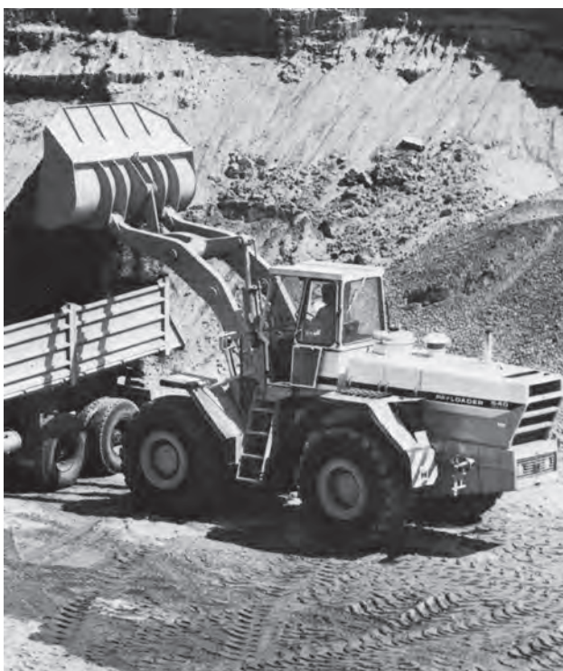
Bild 6.32. Schaufellader beim Beladen eines LKW
