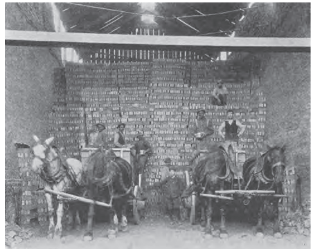
Bild 11.80. Direktes Laden der gebrannten Steine auf Pferdefuhrwerke in einem amerikanischen Feldbrandofen, um 1890
