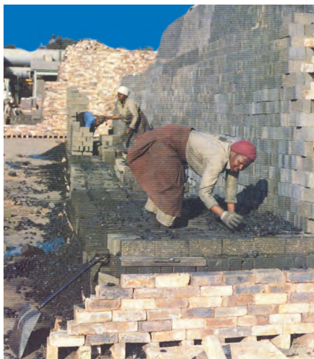
Bild 10.34. Befüllen der Schürkanäle mit Kohle eines südafrikanischen Meilers
