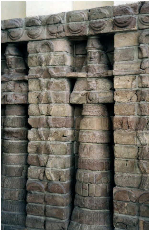
Bild 2.6. Die ersten gebrannten Reliefziegel erschienen während der Herrschaft der Kassiten und Elamiten (etwa 1595 – 1155 v. Chr.). Bekanntestes Beispiel ist die Ziegelfassade im Innin-Tempel in Uruk aus der Zeit um 1450 v. Chr. Der Mauer-ausschnitt befindet sich in den Staatlichen Museen in Berlin.
