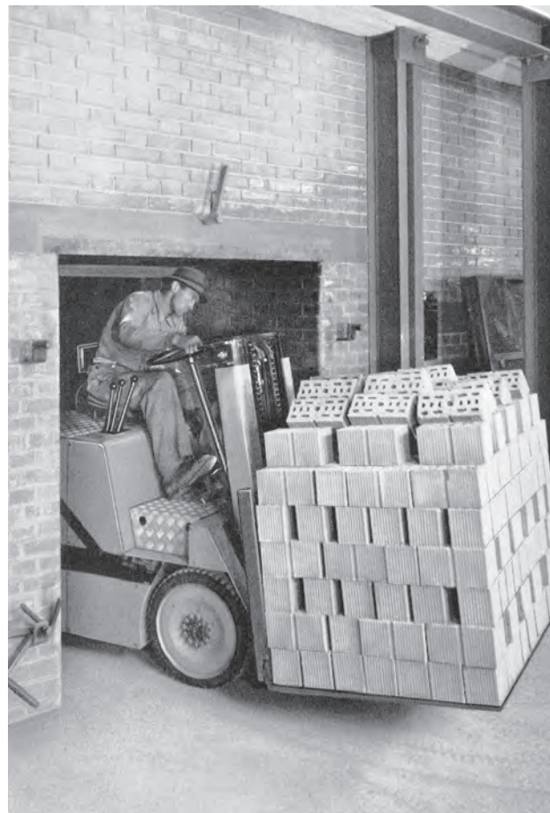
Bild 10.114. Nachträglich vergrößerte Ofentüre eines Ringofens mit Gabelstaplerbetrieb, um 1960
