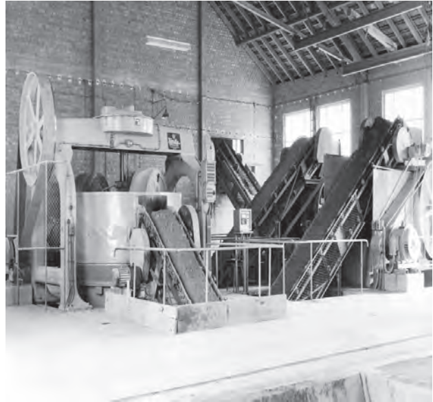
Bild 7.146. Kollergang mit zwei parallel nachgeschalteten Walzwerken, 1960
