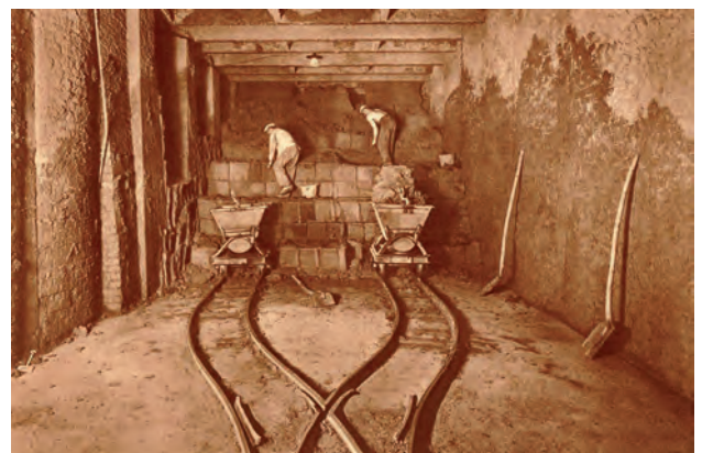
Bild 7.117. Entleerung von Hand und Abtransport des Tons mit Kipploren im Maukkeller eines Dachziegelwerks um 1925
