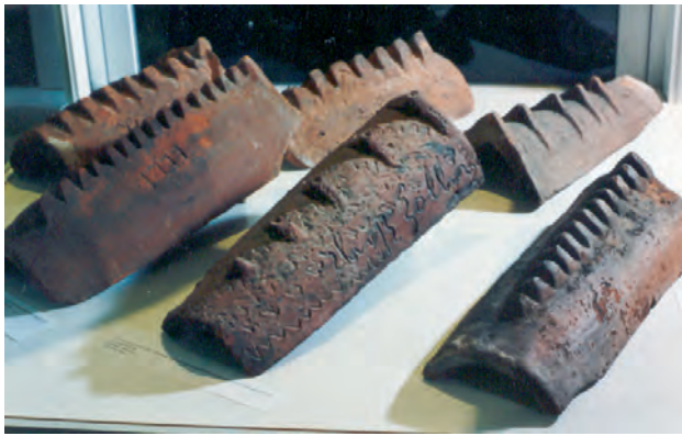
Bild 2.56c. Schmuckfirstziegel, sog. Höckerziegel, die auf der höchsten Stelle der Wölbung eine Reihe von Höckern tragen. Auch Drachenziegel genannt, da man vermutet, daß die Höckerziegel einen stilisierten Drachen darstellen sollen. Bei der Höckerzahl findet sich oft die Zahl sieben, womit vermutlich die sieben Wochentage symbolisiert werden sollen.
