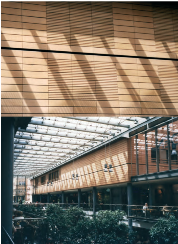
Bild 1.7.b. In den Arkaden: Keramikfassade aus vorgehängten Terrakottaplatten
