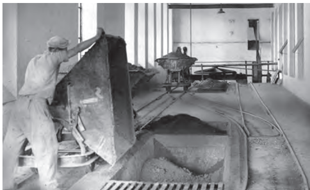
Bild 11.9. Entleeren der Loren in die Kastenbeschicker auf dem Schüttboden
