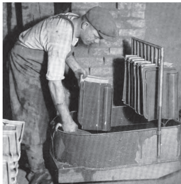
Bild 5.40. Engobieren der getrockneten Rohlinge durch Begießen von Hand, 1935
