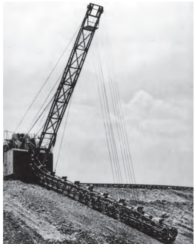
Bild 6.29. Eimerkettenbagger in der Ausführung als Tiefbagger
