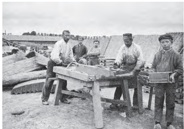
Bild 4.14. Handstrichziegelherstellung in Holland um 1900. Links am Streichtisch der Tonzubringer oder Aufstecher, in der Mitte der Ziegelstricher und rechts der Abtragejunge
