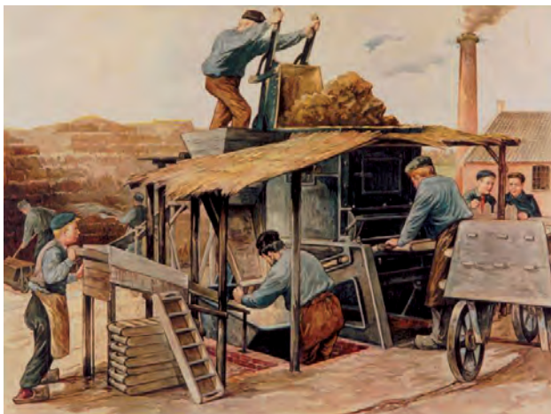
Bild 8.42b. Aberson-Strichmaschine im Einsatz in einer holländischen Ziegelei, um 1900
