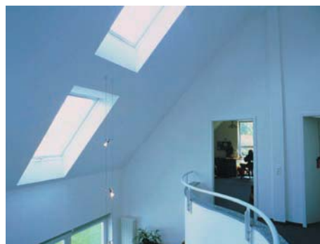
Abb. 3: Der Dachdecker deckt das Dach, baut Zusatzmaßnahmen und Dachflächenfenster ein. Vielen Bauherren erscheint es nützlich, auch den Innenausbau in der gleichen Hand zu belassen.
