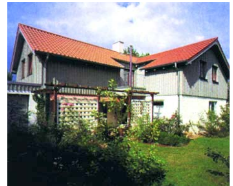
Ansicht des aufgesattelten Hauses von Südwesten
