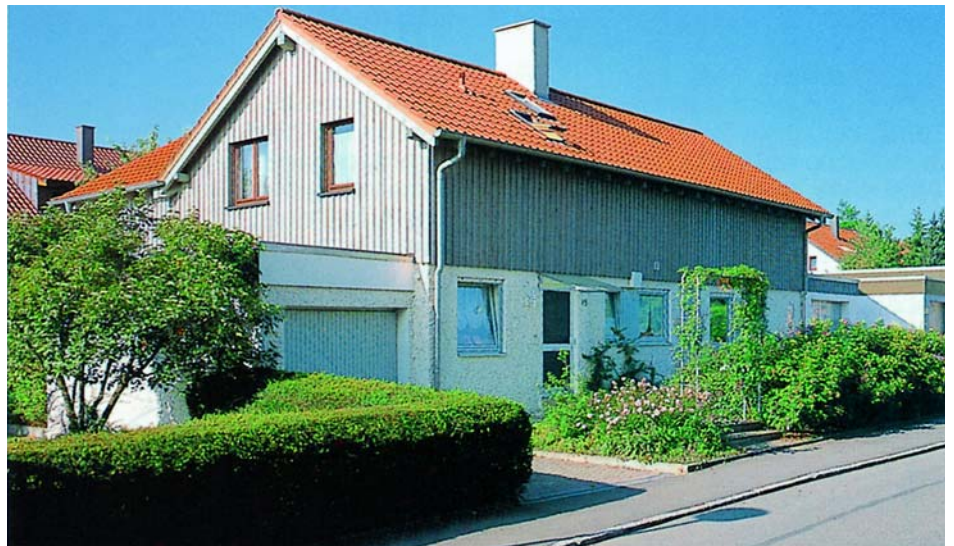
Straßenansicht nach dem Umbau
