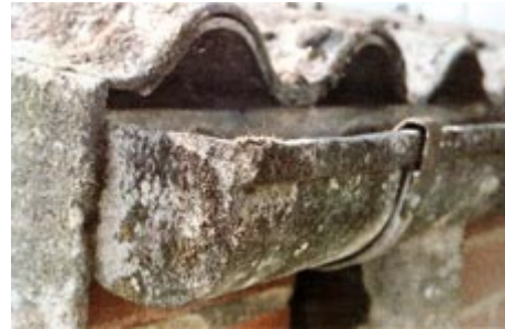
Wellasbestdach und Dachpfanne aus Asbestzement (Foto: Schäffner, „Handbuch der Gebäudeschadstoffe für Architekten, Sachverständige und Behörden“)
