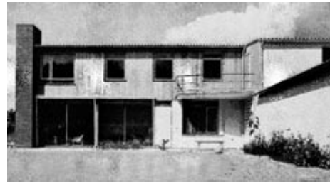
Für die 1950er Jahre typisches Einfamilienhaus mit Wellasbestzementdeckung (Foto: AZD)
