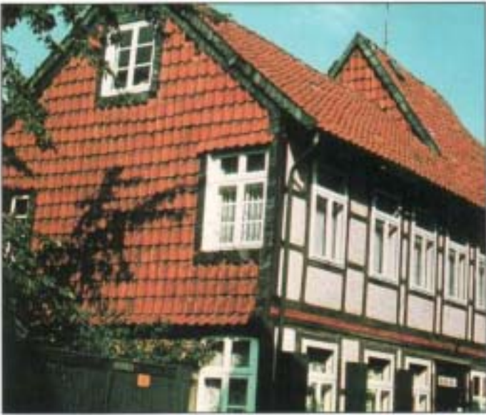
Den Fassadenteilen Schutz zu bieten, die dem Wetter besonders ausgesetzt waren, ist häufig der wichtigste Grund für einen Wandbehang aus Dachziegeln.
