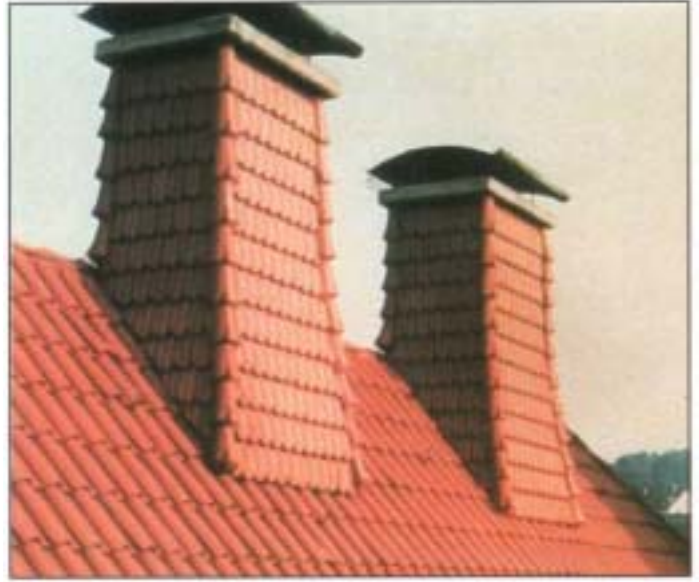
Bekleidung der Schornsteine: So lassen sich die Elemente des Daches optisch vereinheitlichen, bei gleichzeitigem wirkungsvollem Schutz vor der Witterung.
