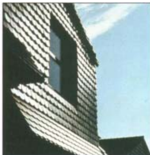
Die Hand des erfahrenen Fachmanns vermag Dachziegel auch mit anderen Materialien zu kombinieren. Hier ist die Fensterumrandung aus Naturschiefer gestaltet.
