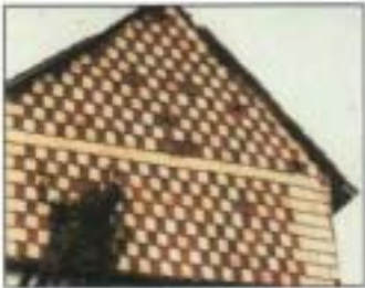
Den Fassadenteilen Schutz zu bieten, die dem Wetter besonders ausgesetzt waren, ist häufig der wichtigste Grund für einen Wandbehang aus Dachziegeln.
