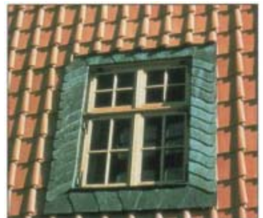
Die Hand des erfahrenen Fachmanns vermag Dachziegel auch mit anderen Materialien zu kombinieren. Hier ist die Fensterumrandung aus Naturschiefer gestaltet.
