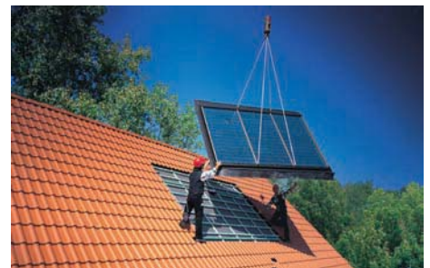
Abb. 9: Montage eines dachintegrierten Thermokollektors zur solaren Warmwassergewinnung
