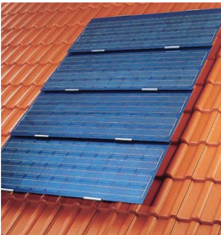
Abb. 11: Auch aufgeständerte Photovoltaikmodule sollten idealerweise vom Dachdecker eingebaut werden.
