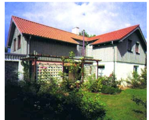
Ansicht des aufgesattelten Hauses von Südwesten
